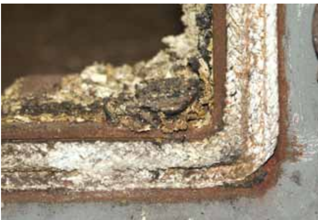
Figura 10 attenzione! Stuoie isolanti (vengono utilizzate soprattutto dietro caldaie o stufe).
