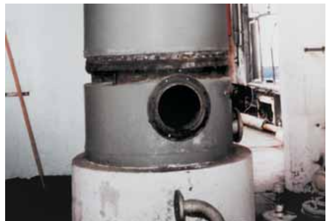
Figura 11 il materiale isolante è spesso ricoperto, ad esempio da una lamina di metallo.
