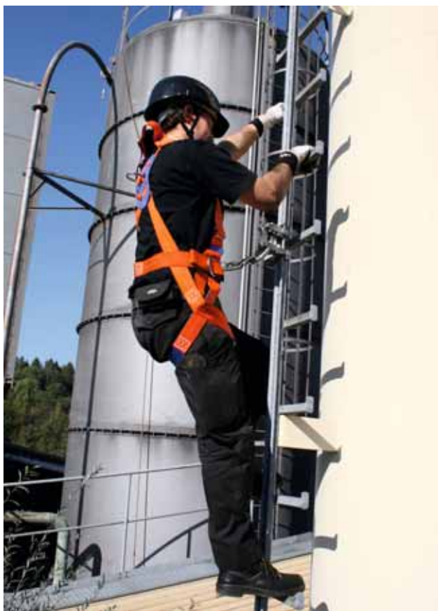
Figura 7 protezione anticaduta con scala e binario di guida su un camino di fabbrica.
