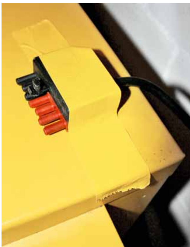
Figura 5 questo piccolo impianto termico è stato spento in sicurezza (seppure in modo un po' improvvisato con del nastro adesivo) di modo che nessuno possa riaccenderlo involontariamente.
